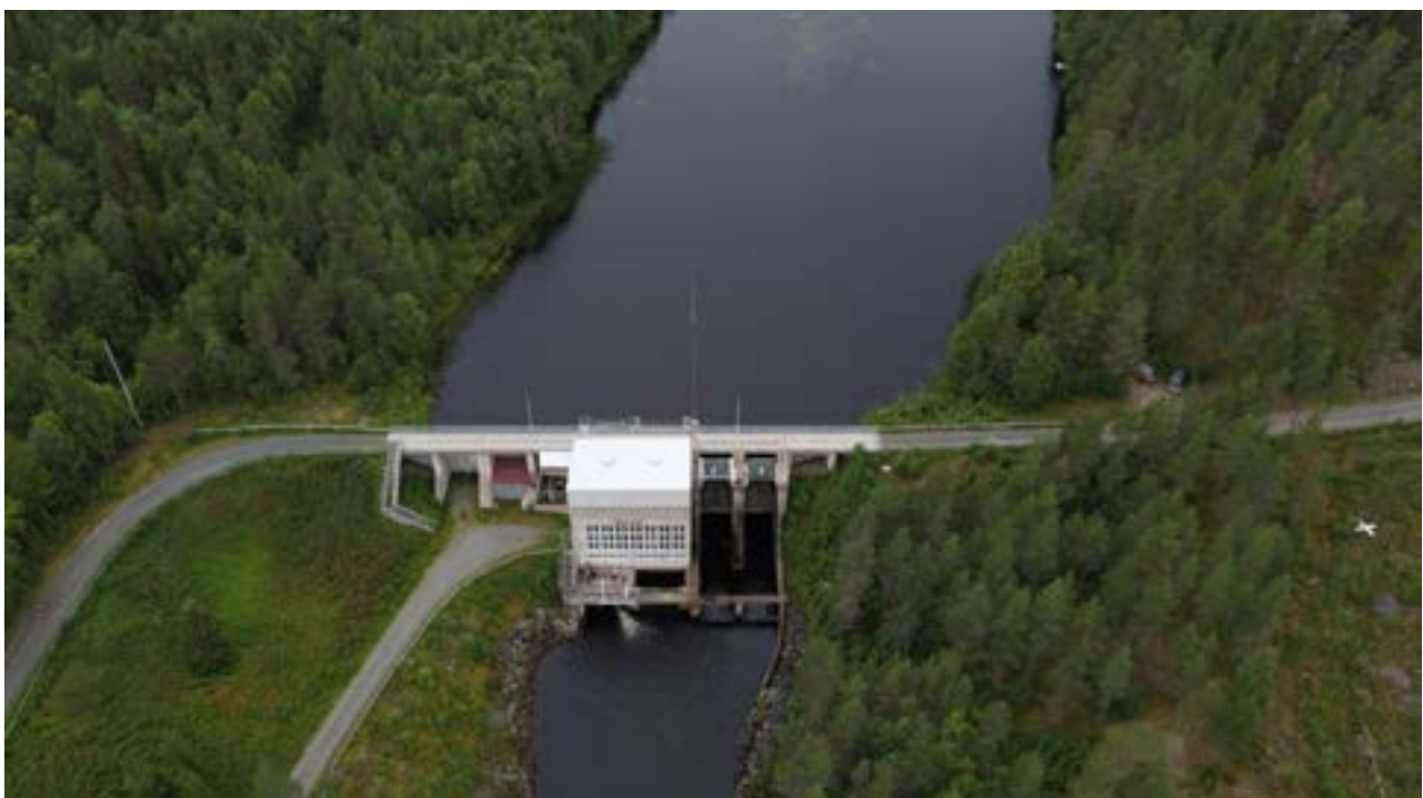
Kuva 10. Ensio Karjalainen. Myllykosken voimalaitos on poistettu käytöstä.
