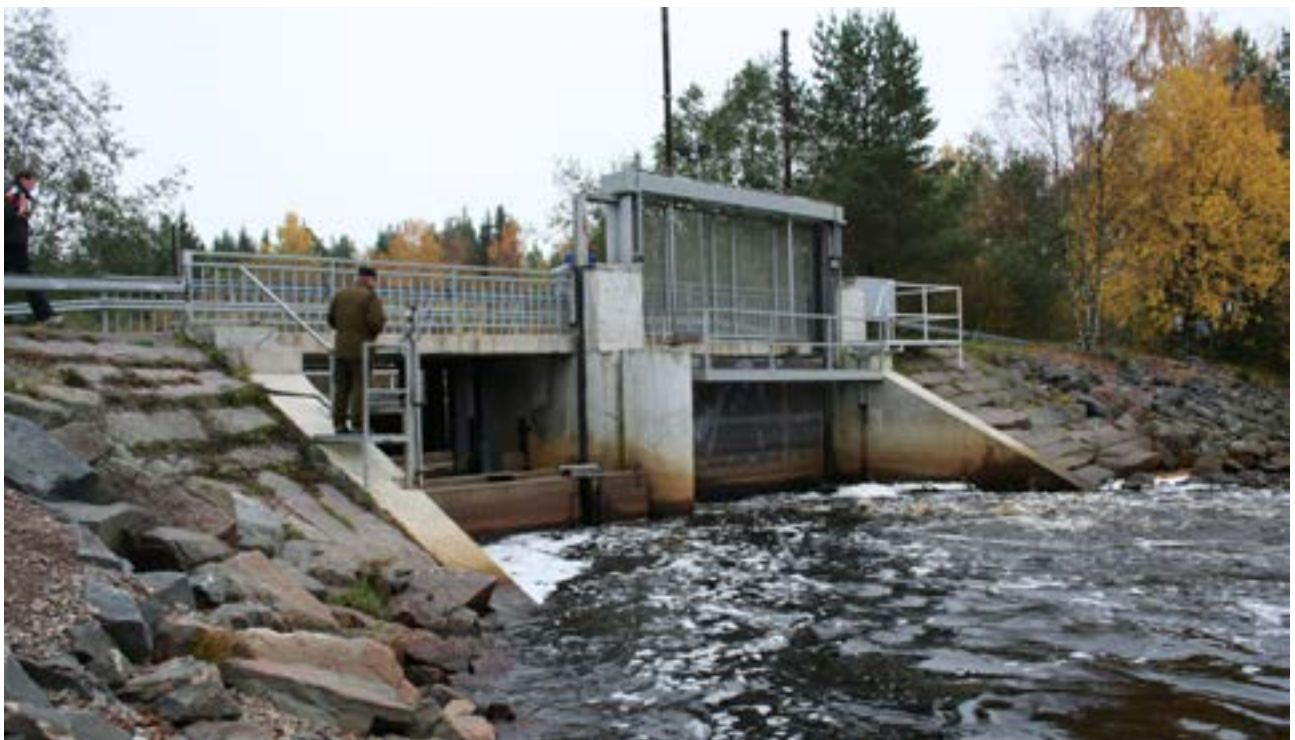
Kuva 13. Kimmo Aronsuu. Piehinginjoella on lähellä jokisuuta sääntöstelypato. Padon yhteyteen on rakennettu kalatie.
