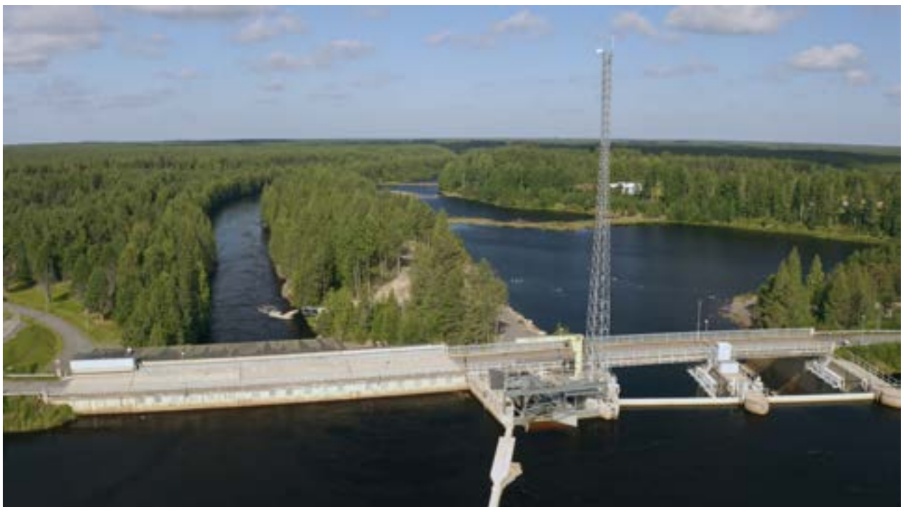
Kuva 3. Pohjois-Pohjanmaan liitto. Iijoen Haapakoskelle on rakennettu Suomen ensimmäinen smolttien alasvaellusreitti.
