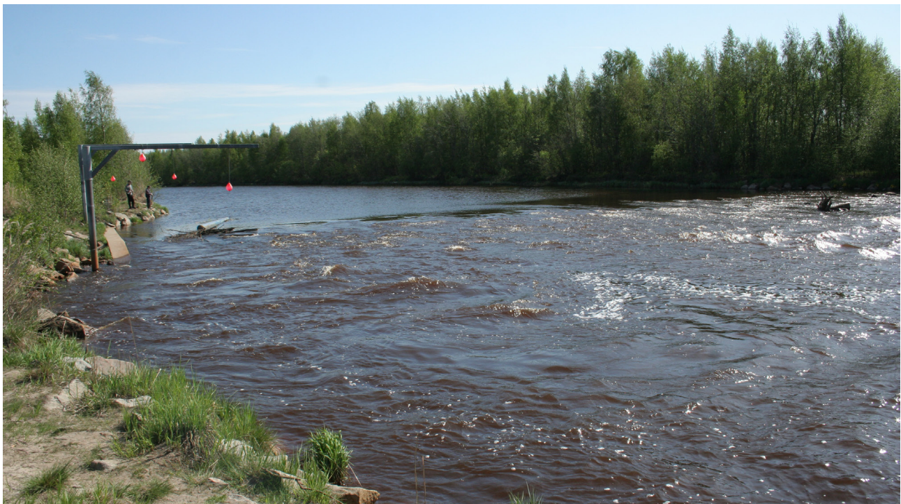
Kuva 9. Kimmo Aronsuu. Temmesjoen alaosan pohjapato. Vasemmalla kuvassa näkyy kalatie/veneväylä.
