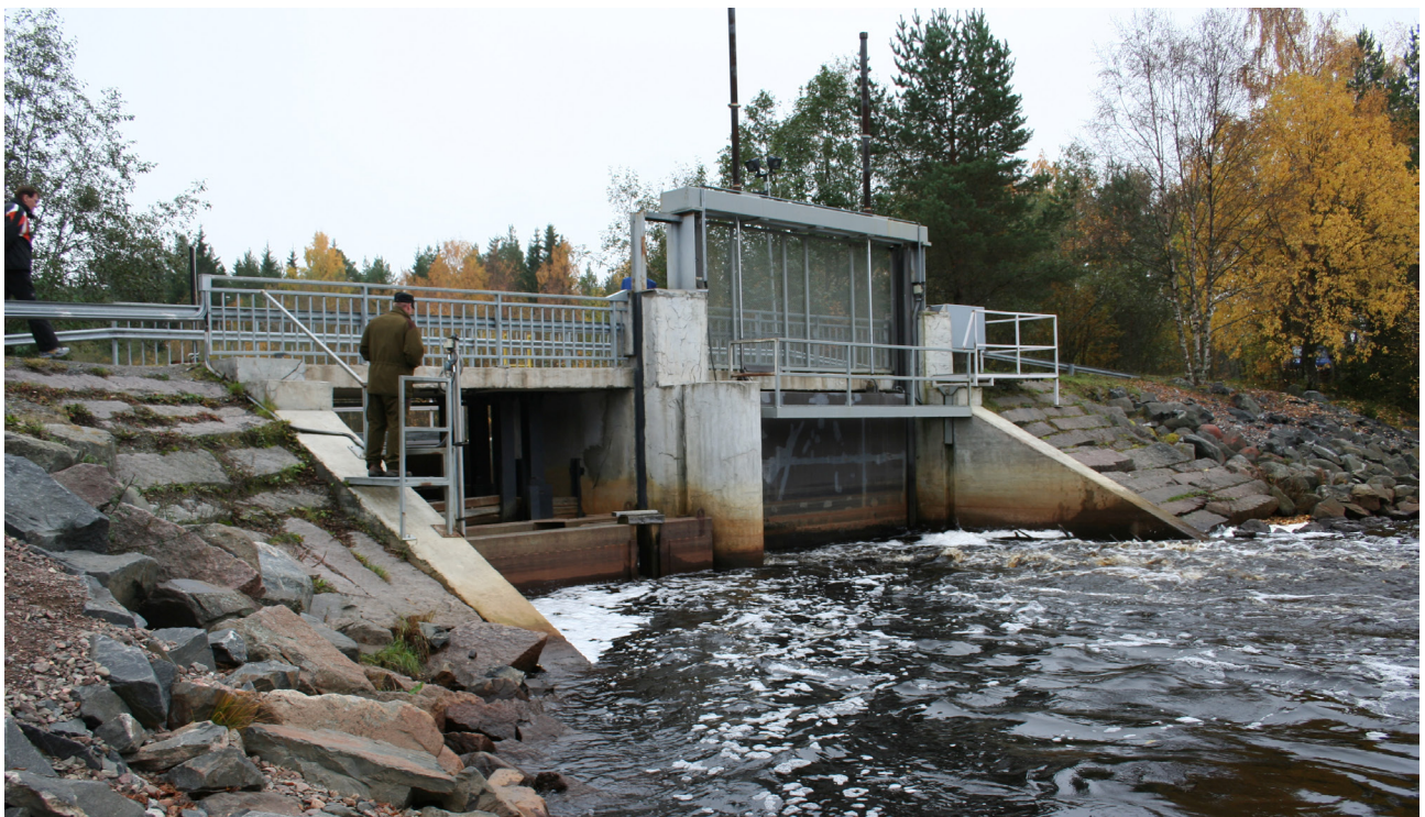
Kuva 13. Kimmo Aronsuu. Piehinginjoella on lähellä jokisuuta säätöastepato. Padon yhteyteen on rakennettu kalatie.
