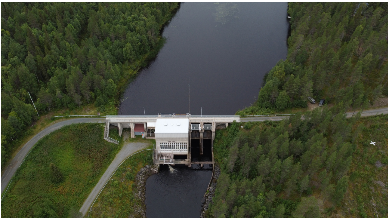
Kuva 10. Ensio Karjalainen. Myllykosken voimalaitos on poistettu käytöstä.
