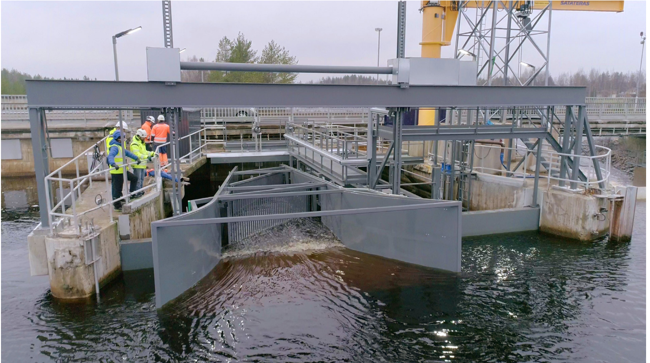
Kuva. Pohjois-Pohjanmaan liitto. Iijoen Haapakoskelle rakennettiin Suomen ensimmäinen smolttien alasvaellusväylä osana Iijoen vaelluskalahanketta 2020–2022.
