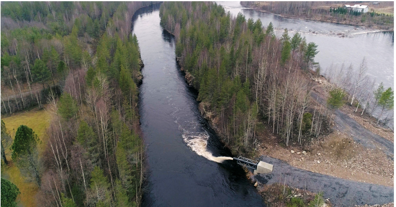
Kuva. Pohjois-Pohjanmaan liitto. Smolttien alasvaellusväylä mahdollistaa kalojen vaelluksen voimalaitoksen ohi. Kalat päätyvät voimalaitoksen alakanavaan putkea pitkin.
